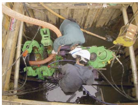
発生土撤去状況
