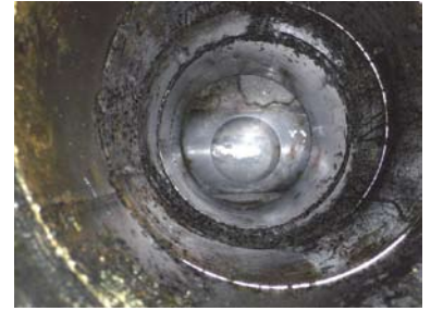
コア抜き状態
