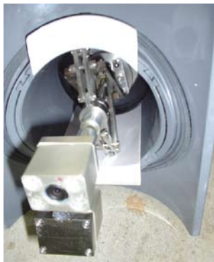
施工後の撮影確認
